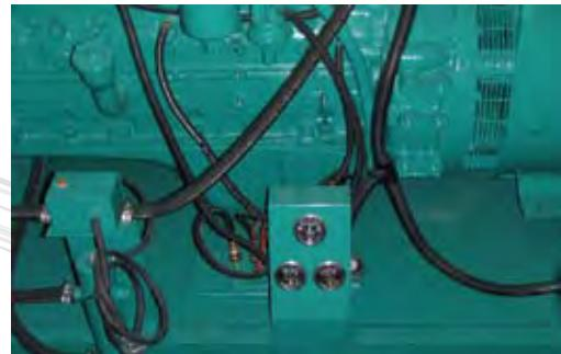
**Mantiene cargadas las baterías.** El Mantenedor de Carga vigila las condiciones correctas de las baterías y las mantiene en flotación, listas para ser utilizadas. Además del Mantenedor de Carga, la planta eléctrica cuenta con un Alternador de Corriente Directa, que tiene la función de cargar rápidamente las baterías después de haberseles requerido en el arranque, dejándolas así, listas si se necesita que la planta opere nuevamente.
